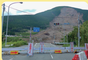
災害時の状況（基幹道路崩落）
