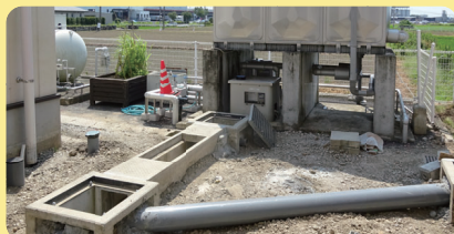
受水槽付近の被害
