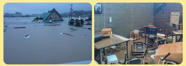
1階が完全に浸水 水がひいた後の状況
