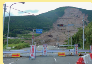
災害時の状況(基幹道路崩落)
